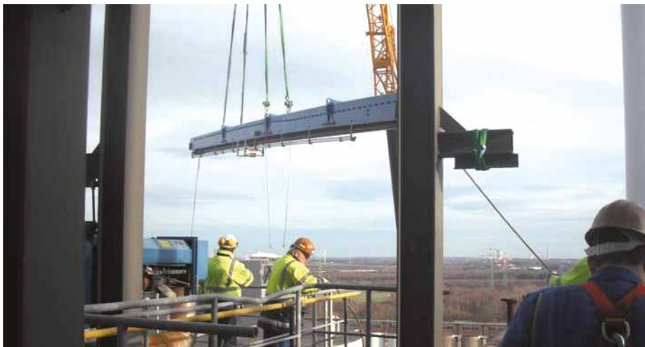
Einbau des RS-M Rußbläfers
