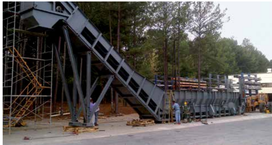
Prüfung und Werksmontage des neuen Nassentschlackers in Atlanta
