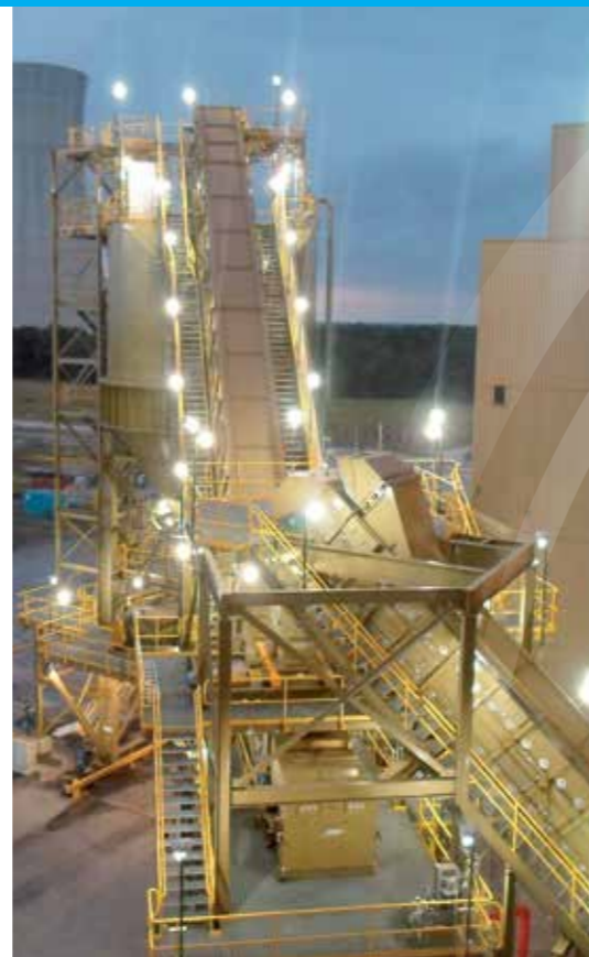
► DRYCON™ – Clyde Bergemanns System zur Trocken-Bodenentaschung
