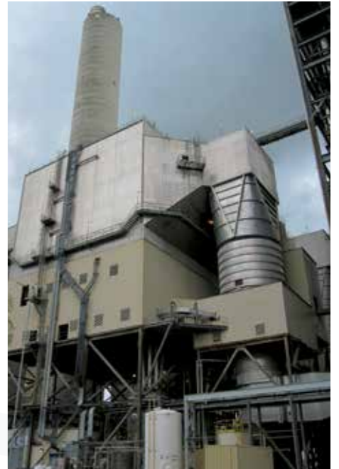
Installiertes CDS-System
