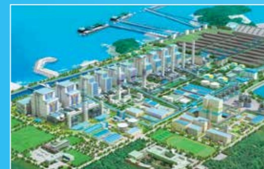
Südkoreas größtes Steinkohle-Kraftwerk in Taeon mit den beiden neu geplanten 1.050 MW Kesseleinheiten (links).
