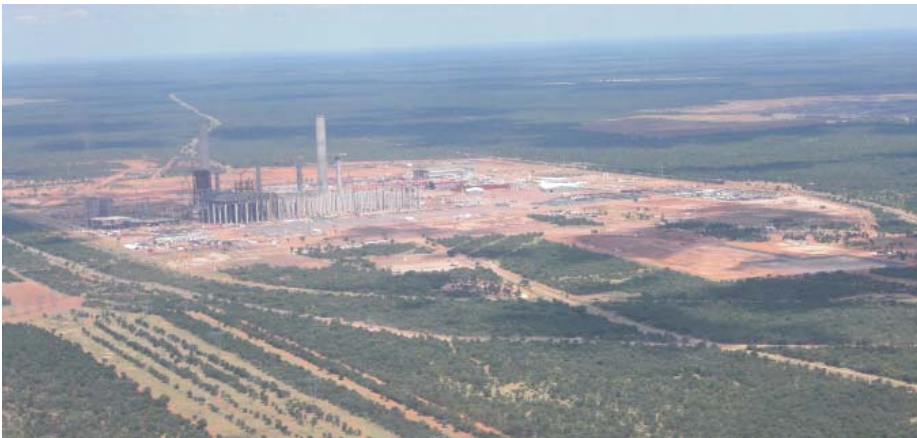
Blick auf die Kraftwerksbaustelle
