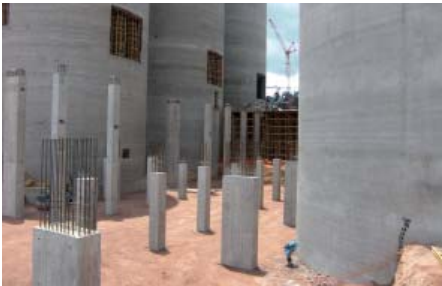
Vorbereitungen für einen Abschnitt des Flugaschefördersystems
