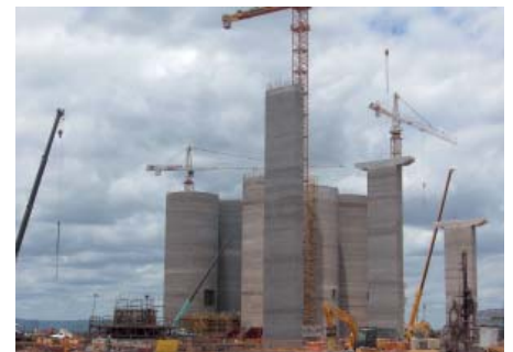
Bau der Aschesilos
