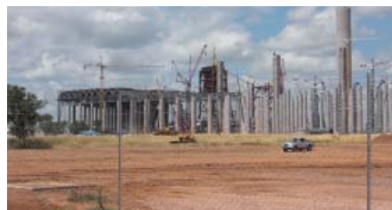
Blick vom Baustellenbüro zur Baustelle
