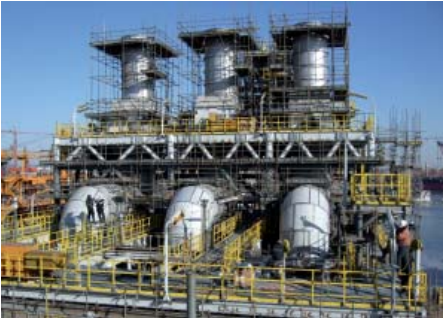
Abhitzeessel auf dem FPSO-Schiff „Guara“ von Modec
