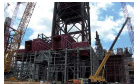
Bauarbeiten sind in vollem Gange
