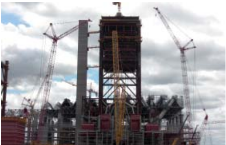
Der erste von sechs superkritischen Dampferzeugern entsteht
