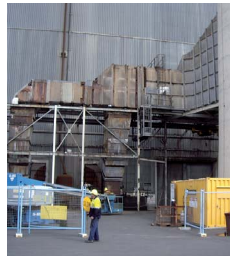
Die Umbauarbeiten haben begonnen
