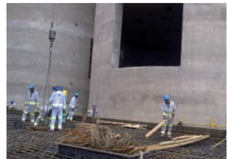
Der Bereich zur Ascheaufbereitung entsteht
