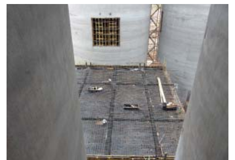
Blick zwischen die Silos auf die Ascheaufbereitung
